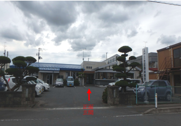
当組合の入口付近 ←写真は、上の地図の赤丸から撮影
